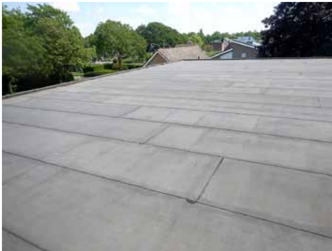
het hoofddak; bitumen dakbedekking
