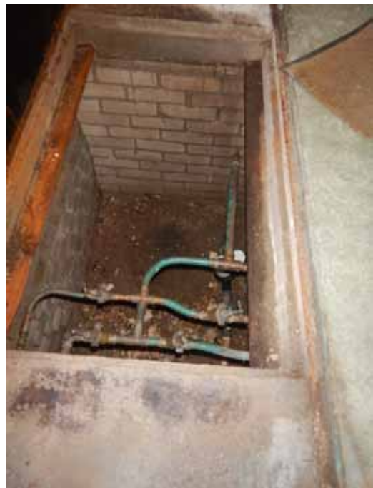
vochtinwerking en roestend hoekijzer rondom luik watermeterput
