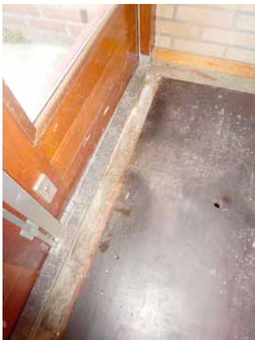
vochtinwerking en roestend hoekijzer rondom luik watermeterput
