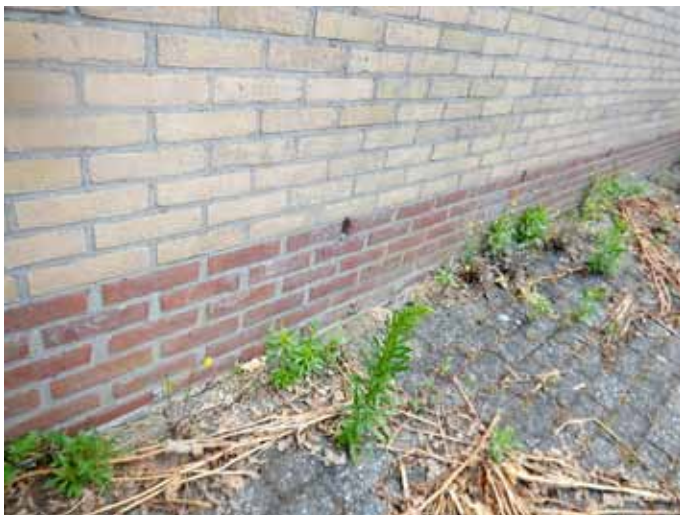
open stootvoegen t.b.v. ventilatie spouw
