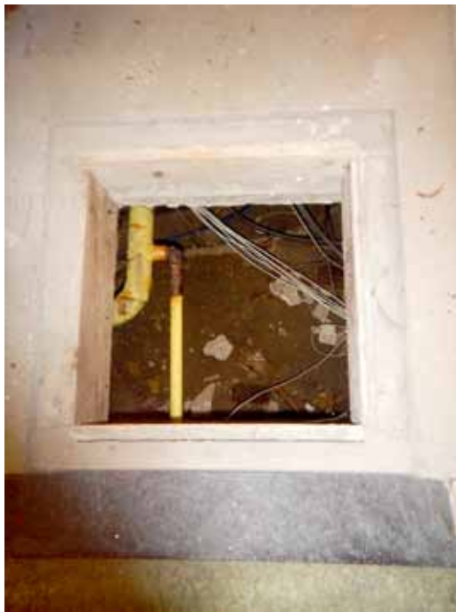
de kruipruimte tpv ruimte nr. 18
