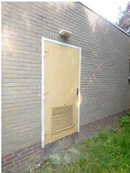
deur in achtergevel t.b.v. cv-ruimte
