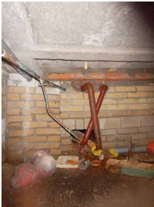
nogmaals zwaar roestend leidingwerk in kruipruimten
