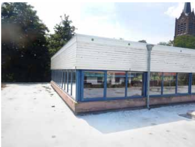
aanzicht hoek linkerzijde voorgevel
