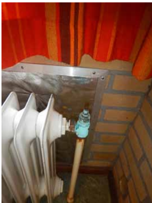
idem; radiatorknop mist, roestend leidingwerk
