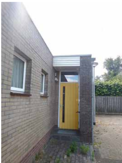
entree tpv rechterzijgevel
