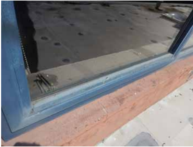
kozijnen verhoogd deel zijn in matige staat
