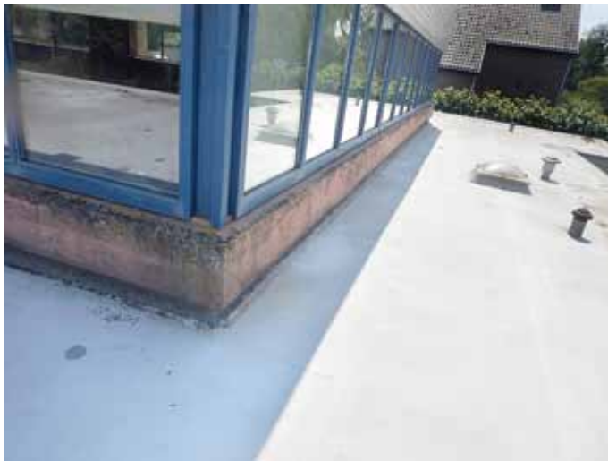
aanzicht hoek rechterzijde voorgevel
