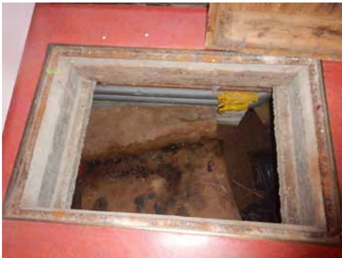
de kruipruimte tpv ruimte 9
