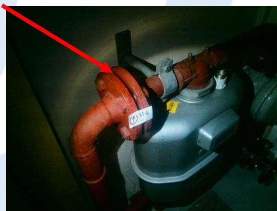
Foto 10 | Flenspakkingen gasmeter
