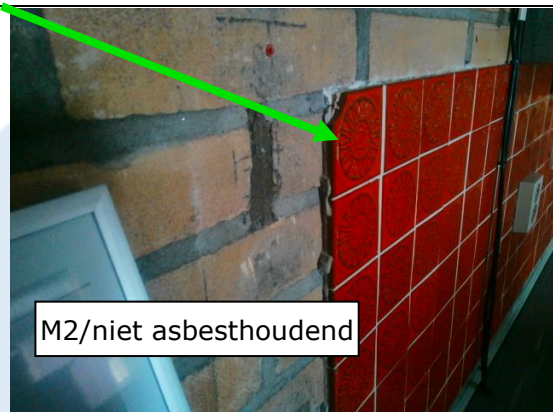
Foto 5 | Tegellijm wandtegels bar
