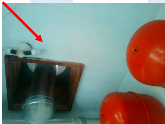
Foto 11 | Brandwerende plafondbeplating cv-ruimte
