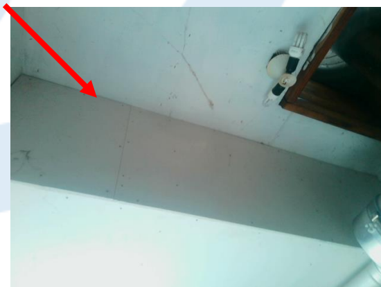
Foto 12 | Brandwerende plafondbeplating cv-ruimte
