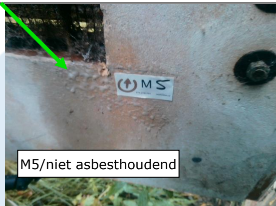
Foto 16 | Beplating op deur cv-ruimte
