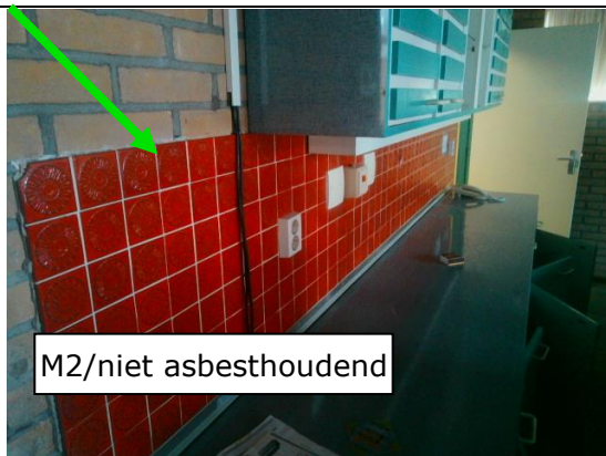
Foto 4 | Tegellijm wandtegels bar
