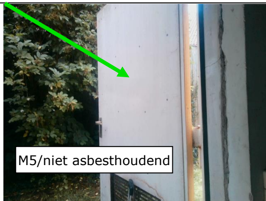
Foto 15 | Beplating op deur cv-ruimte
