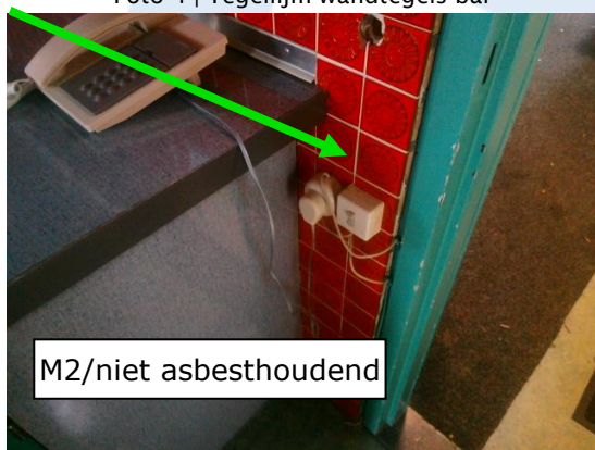
Foto 6 | Tegellijm wandtegels bar
