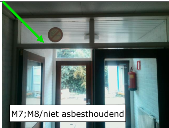
Foto 33 | Beglazingskit binnen kozijnen
