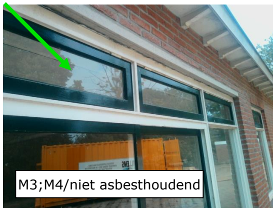
Foto 13 | Beglazingskit enkel glas
