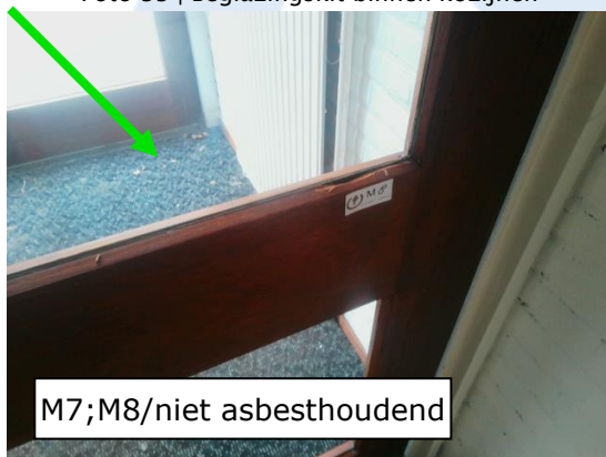
Foto 35 | Beglazingskit binnen kozijnen
