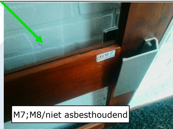
Foto 34 | Beglazingskit binnen kozijnen
