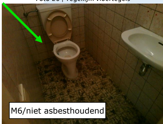
Foto 28 | Tegellijm vloertegels
