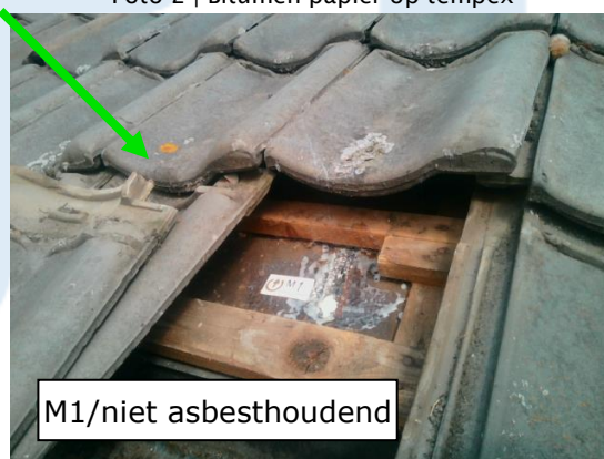
Foto 4 | Bitumen papier op tempex
