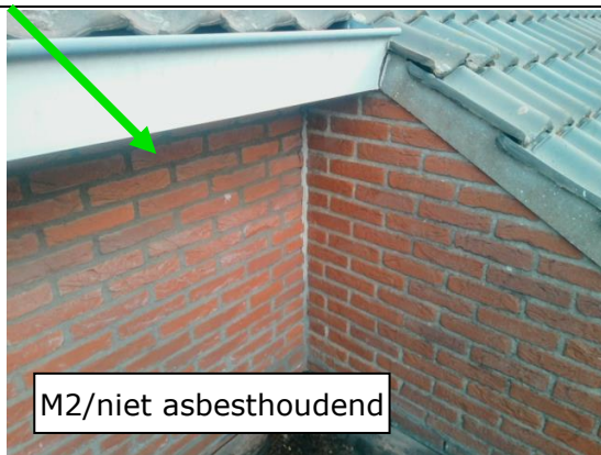
Foto 5 | Kit in metselwerk
