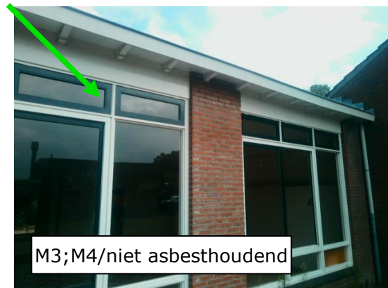
Foto 14 | Beglazingskit enkel glas
