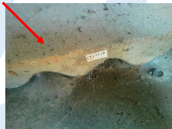
Foto 40 | Golfplaat in fundering oude cv
