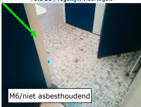
Foto 30 | Tegellijm vloertegels
