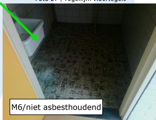
Foto 29 | Tegellijm vloertegels
