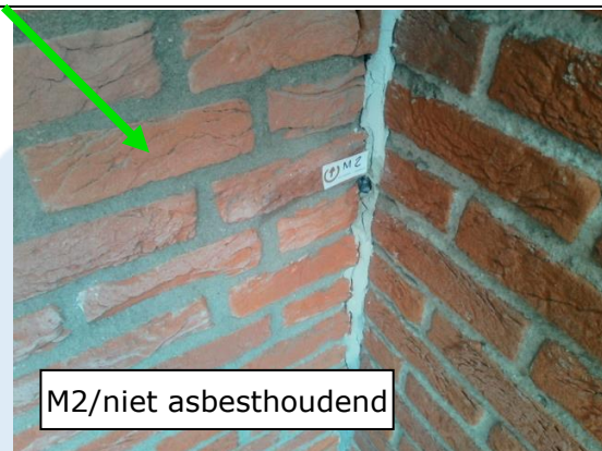
Foto 6 | Kit in metselwerk
