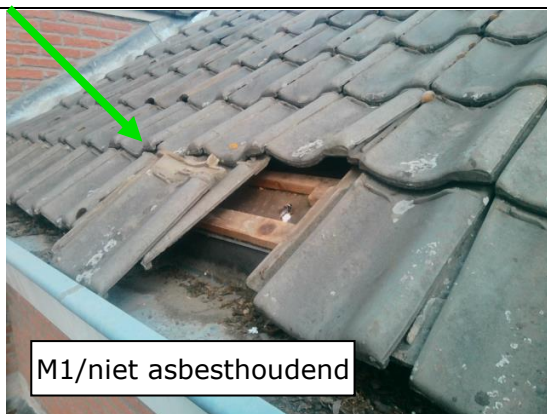
Foto 1 | Bitumen papier op tempex
