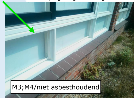
Foto 16 | Beglazingskit enkel glas
