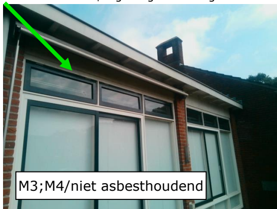
Foto 15 | Beglazingskit enkel glas
