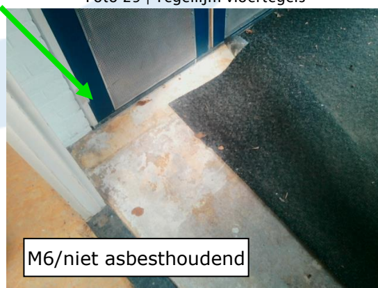
Foto 31 | Tegellijm vloertegels
