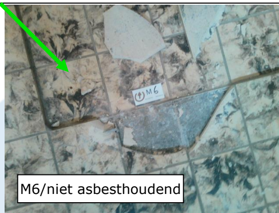
Foto 27 | Tegellijm vloertegels
