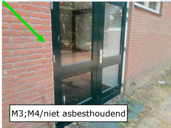
Foto 17 | Beglazingskit enkel glas
