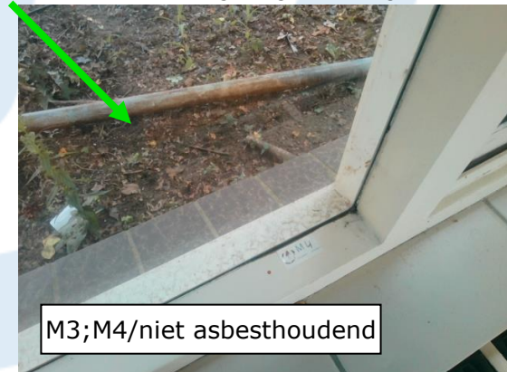
Foto 18 | Beglazingskit enkel glas
